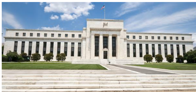
Федрезерв. Кузнец собственного несчастья. Фото: iStock
